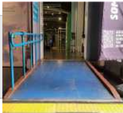
Rampa de Acesso - Conforme Normas ABNT
